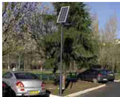
Exemple de réalisation sur le parking d'une clinique
