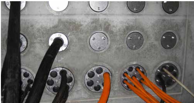
HRD150 SG intégré dans des gaines en fibrociment
