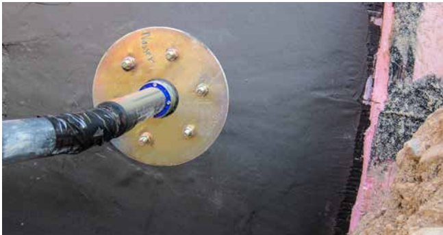
FLFE 1x300/X A3C avec joint annulaire standard HSDC (revêtu par poudre)
