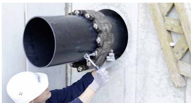
GKD400 - serrage des segments
