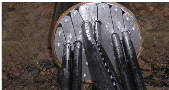
HRD200 G b30 dans un tube en acier
