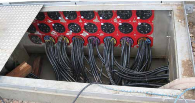
HSI150 - passages étanches avec étanchéification SEGMENTO des lignes de commande dans une cabine de distribution
