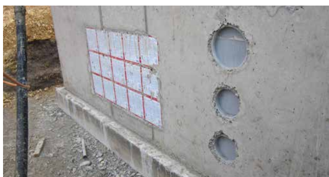
ZVR150 et ZVR200 bétonné près de HSI150
