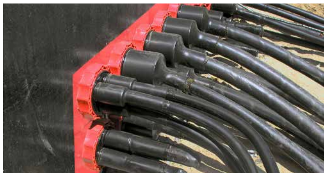
entrée de poste de transformation: câbles basse tension étanchéifiés HSI90 D1x75 WS and HSI90 D3x32 WS
