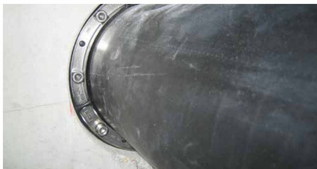
Vue détaillée - HSD, ouverture de contrôle et ordre de serrage des vis
