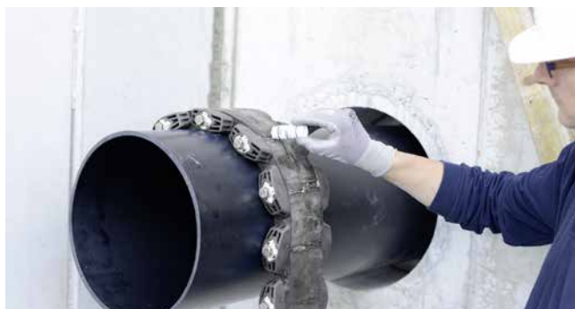
GKD400 - préparation de l'installation avec lubrifiant GM
