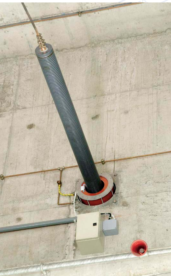
Wanddurchführung Wall bushing Traversée murale 145 kV - 400 A
