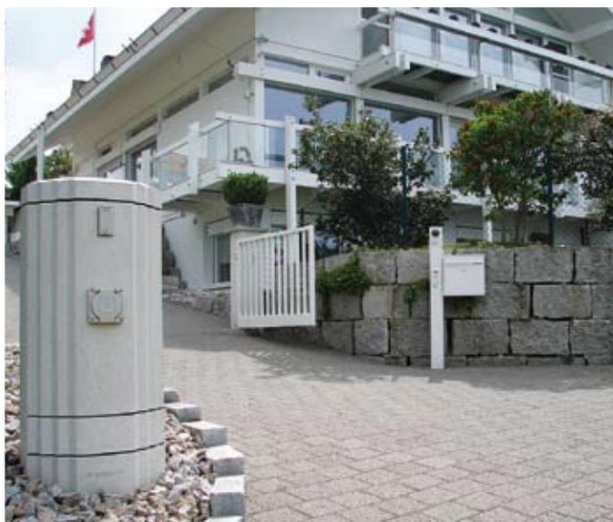
La *colonne de raccordement type KVS* isolée offre une indépendance maximale pour le raccordement par le fournisseur sur le bâtiment.
