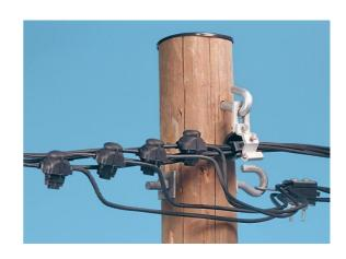
Pince d'ancrage à serrage mécanique pour torsade autoportée à conducteur isolés constitué par :
